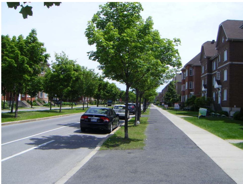
FIGURE 8. L'AVENUE ALEXIS NIHON ET SES ZONES TAMPONS DE CHAQUE CÔTÉ DE LA VOIRIE DOUBLÉES D'UNE VOIE CYCLABLE ET D'UNE VOIE RÉSERVÉE AU STATIONNEMENT DES VÉHICULES.
