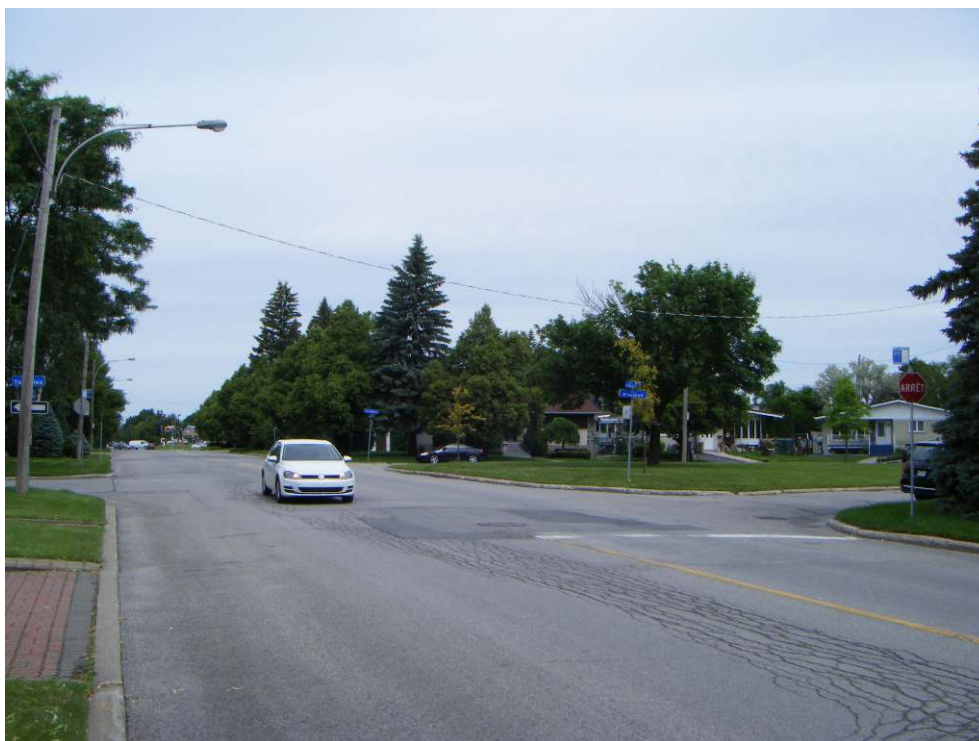
FIGURE 5. ABSENCE DE TROTTOIRS ET DE PASSAGES PIÉTONS SUR LE BOULEVARD D'AUTEUIL DANS LE QUARTIER DE DUVERNAY
