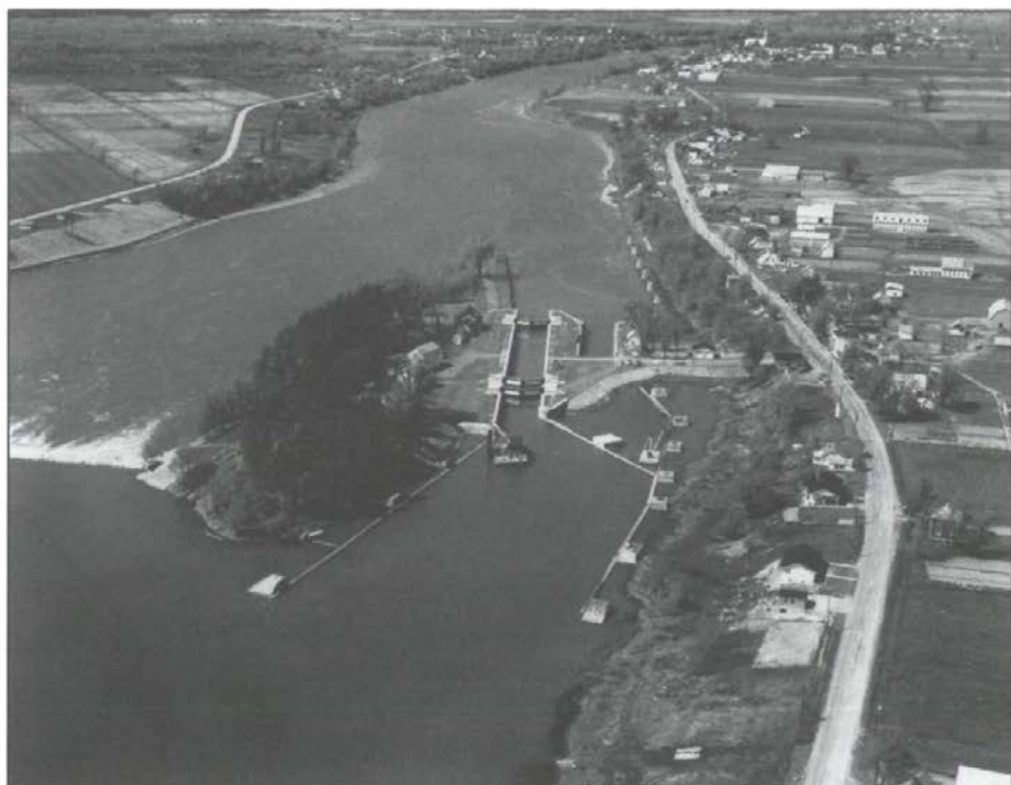
L'île d'Avard et l'écluse moderne de Saint-Ours avant 1965. À l'est, l'écluse de 1849, partiellement visible.
