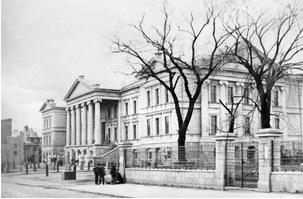
Fig. 7 William Notman (1826-1891), Palais de Justice de Montréal , 1866, photographie. John Ostell, architecte, bâtiment inauguré en 1857. Photo : © Musée McCord, I-20774.1.
