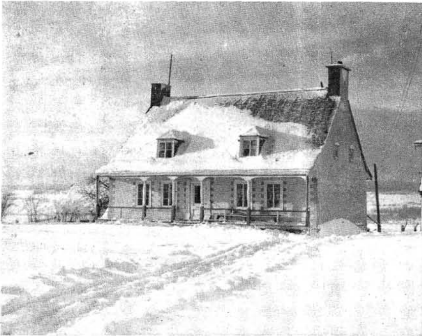
L'introduction de matériaux standardisés : bardeaux d'asphalte, tôle et revêtement en imitation. Il s'agit ici d'une vieille maison, à Sainte-Famille.
