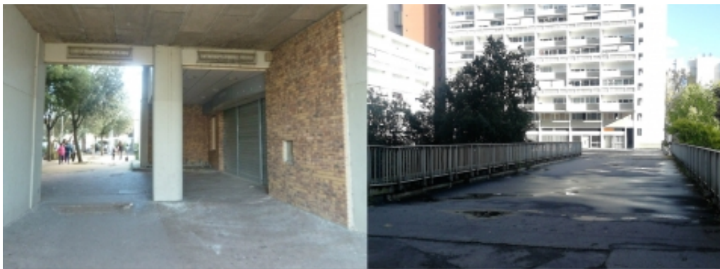
Fig. 4 - Passage sous la dalle et dalle de la résidence des Aubiers
