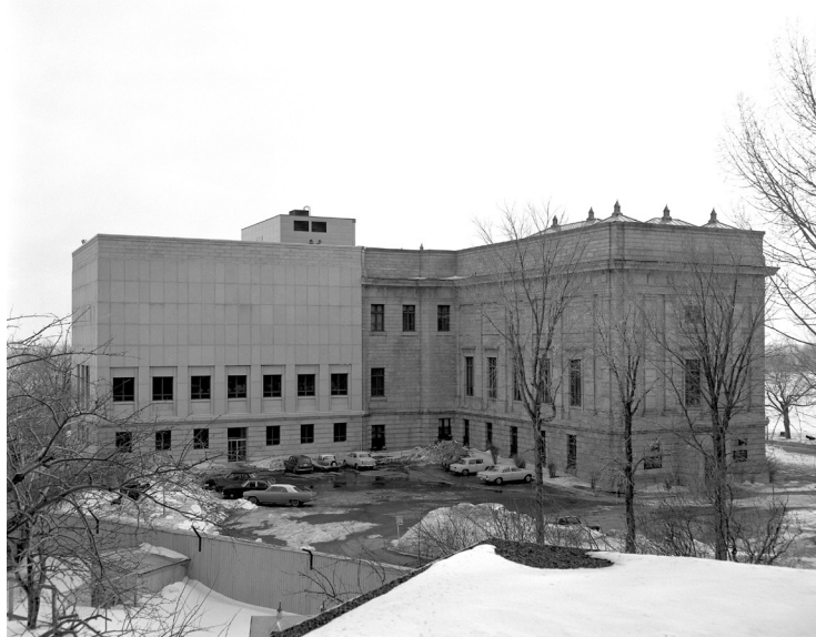
Fig. 17 La nouvelle annexe du Musée construite en 1961-1962, à l'est du pavillon d'origine du Musée de la Province. © Photo : Neuville Bazin, 1964, BAnQ, Centre d'archives de Québec, série Office du film du Québec.
