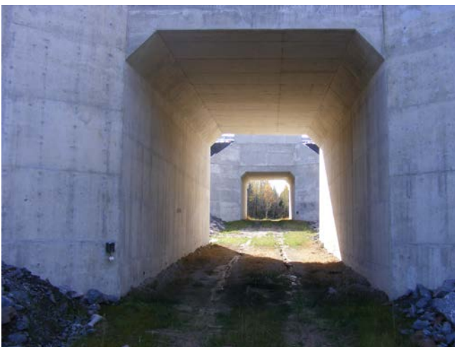
Figure 3. Le passage faunique inférieur (écoduc) de Burwash comprend 2 ponceaux carrés identiques et une ouverture médiane clôturée.
