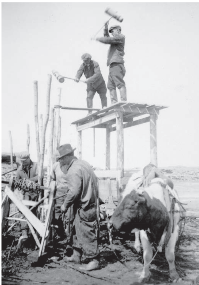
Construction d'une pêche à anguilles requérant deux masseurs et deux autres ouvriers à Saint-Denis-de-la-Bouteillerie, vers 1936
