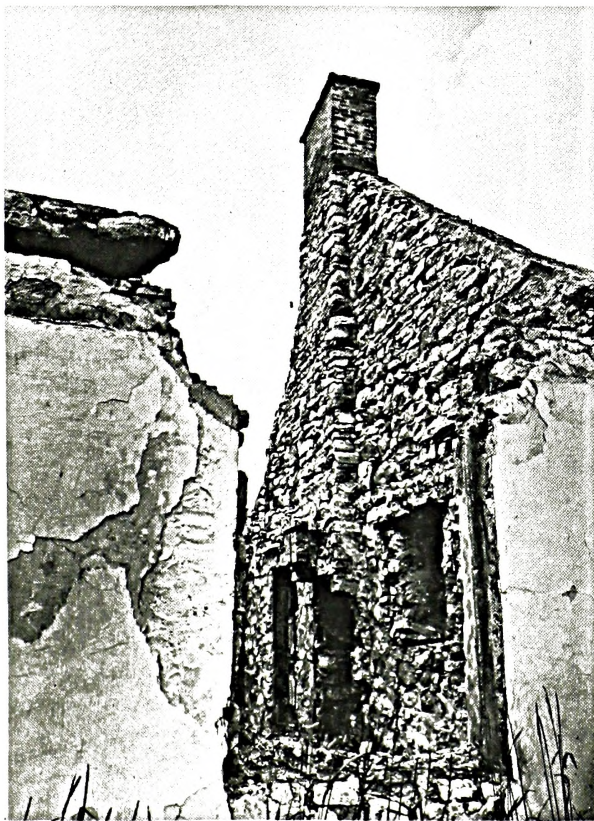
Beauport, Cheminée sur pignon. Gauthier-Larouche, Figure 8-14.
