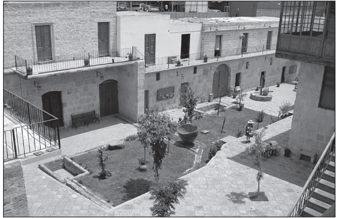
ILLUSTRATION 2 : Tambo La Cabezona, ensemble de logements modestes restauré entre 2006 et 2010, Arequipa (Pérou) (photo : Mathieu Dormaels).
