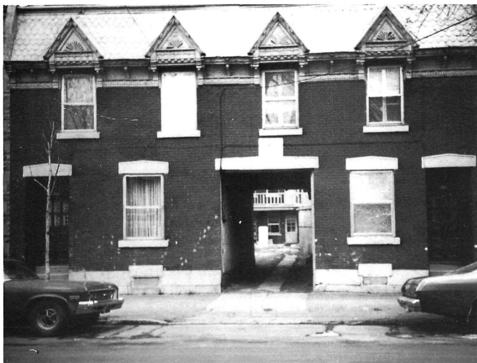
Quartier Centre-sud à Montréal : maisons ouvrières construites à la fin du XIXe siècle et logements en «fond de cour» accessibles par une porte cochère.
