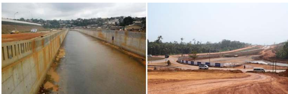
Figure 8. Images de la canalisation de la rivière Mfoundi et de l'autoroute Yaoundé-Nsimalen.
