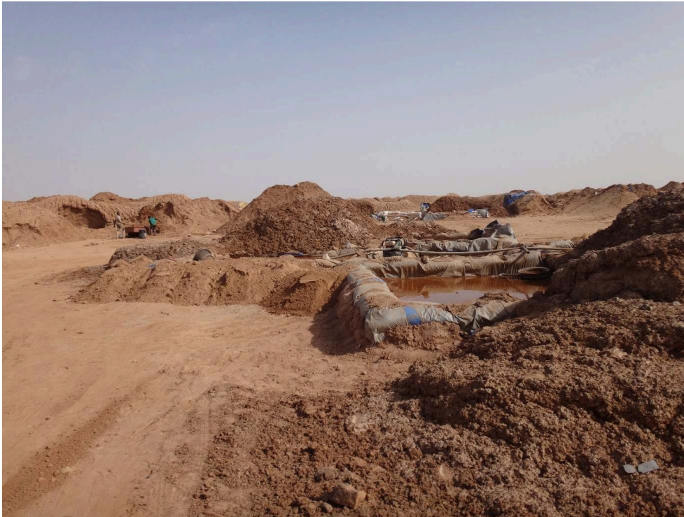
Figure 8. Haldes stockées et bassin de lixiviation sur le site de traitement par cyanuration près d'Agadez / Stockpiles and leaching basin at the cyanidation processing site near Agadez.
