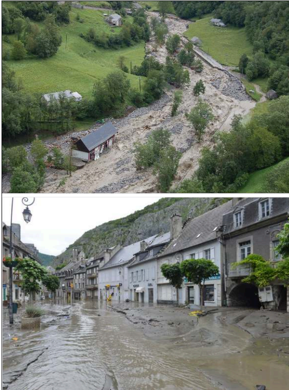
Figures 6a et 6b – La crue et ses effets dans les vallées du Bastan (en haut) et de la Garonne (en bas)
