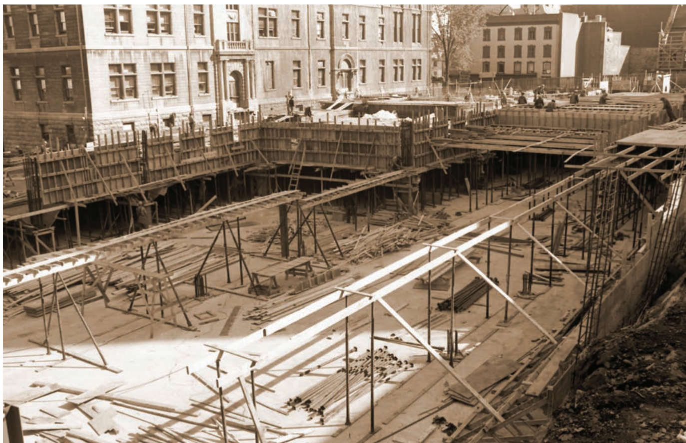
Excavation pour la construction de l'autoroute Dufferin-Montmorency. (Centre d'archives de Québec, Bibliothèque et Archives nationales du Québec).
