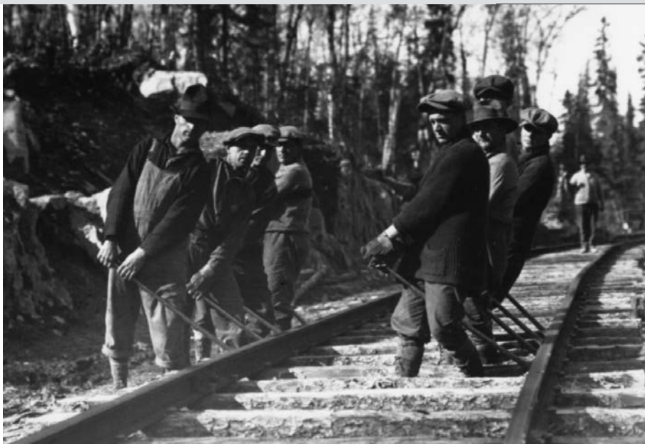
Construction du tronçon de chemin de fer reliant Taschereau à Noranda, 1926. (Coll. Canadien National).
