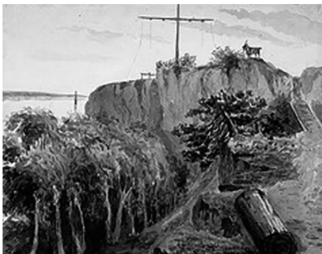
Le mât de télégraphe optique de la Grosse Île à l'endroit où sera construite la croix celtique en 1909. Aquarelle de Henry Hugh Manvers Percy vers 1838-1840. (Bibliothèque et Archives Canada).
