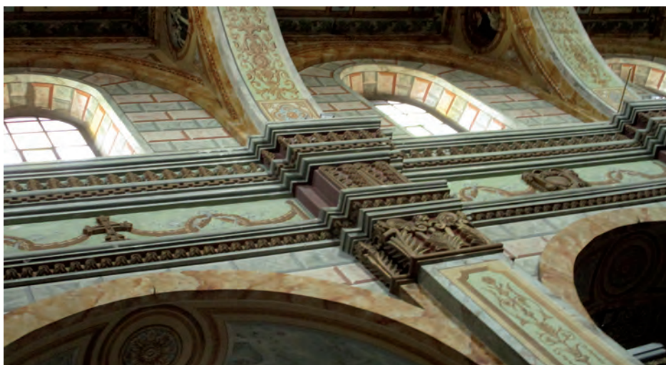
Les décors peints des églises équatoriennes ont notamment recours au trompe-l'œil pour imiter des matériaux nobles.
