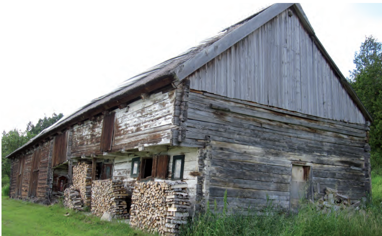
Grange-étable Bhérier de Cap-à-l'Aigle, à La Malbaie. Cette construction à encorbellement, de tradition allemande, a été bâtie en bois pièce sur pièce et dotée d'une toiture en chaume.
