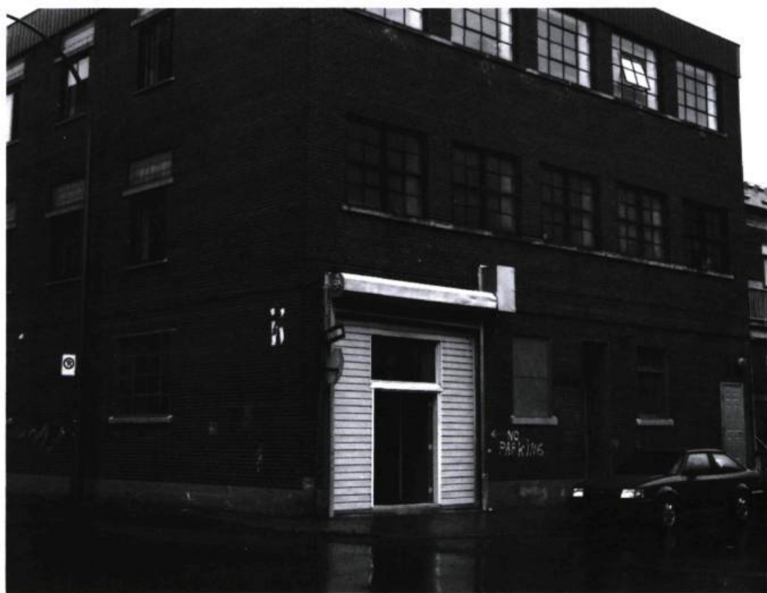
Vue extérieure de l'entrée, au coin des rues Marie-Anne et Clark.
