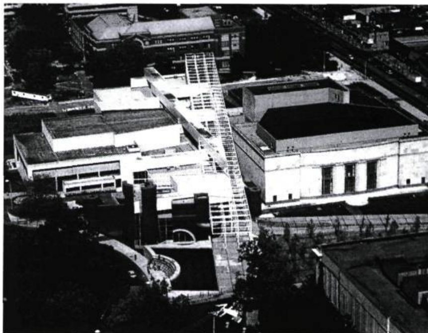
Peter Eisenman, Wexner Center for the Visual Arts , Ohio University, Columbus, Ohio, 1985-1989. Vue aérienne.
