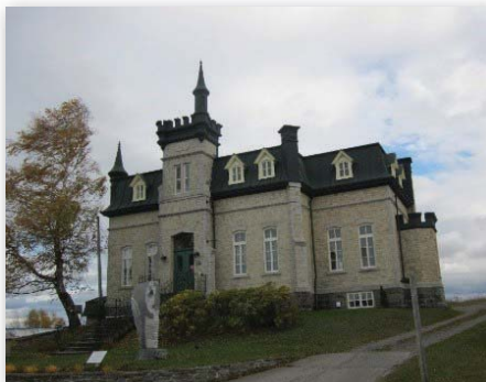
Vue d'ensemble des composantes architecturales de l'ancien palais de justice.
