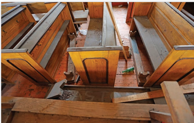
Détail de l'intérieur de l'église. (Photo Pascal Huot, avril 2018)
