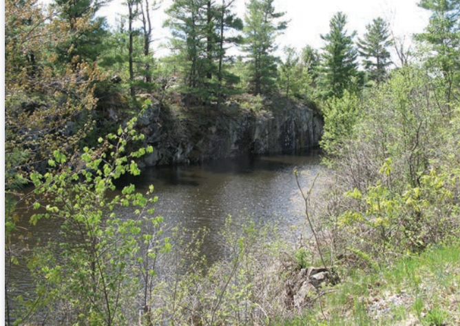
Premier bassin d'éclusement du canal des Chats. Photographie : Maude-Emmanuelle Lambert.
