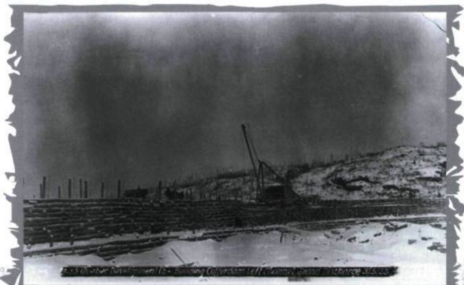
Batardeau construit en amont du site de la centrale servant à assécher le lit de la rivière.
