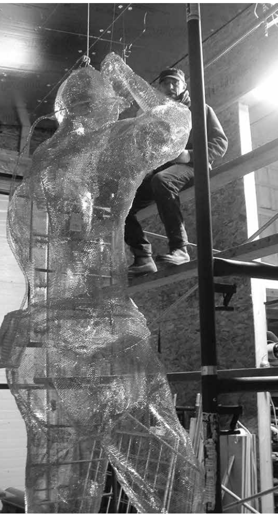
Création de S.A.M. , pour Symbole d'Avenir de Murdochville. Cette sculpture en lattes métalliques recouvertes de fibre de verre est présente sur le site du Centre d'interprétation du cuivre à Murdochville depuis 2013.
