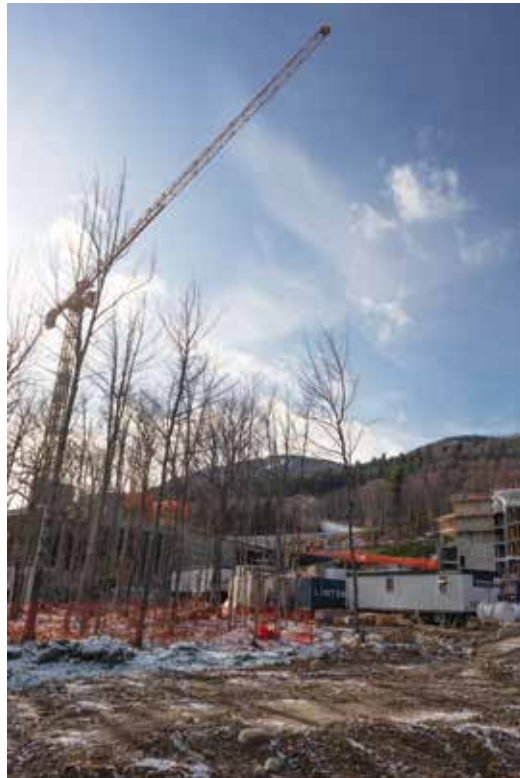
Chantier du Club Med, novembre 2019. Photo: Véronimot
