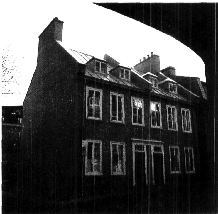
Fig. 6. Maisons situées au 1-3, rue du Parloir, construites pour les ursulines de Québec d'après les plans de Thomas Baillaigé (photo Paul Laliberté).
