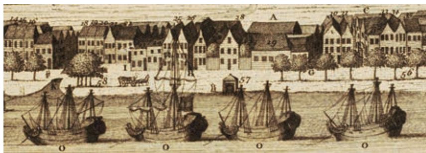
Figure 19 : Détail sur le quai Waterkant à Paramaribo ca.1750 montrant le long du quai, le bâtiment n° 57 pour la pesée des cafés.
