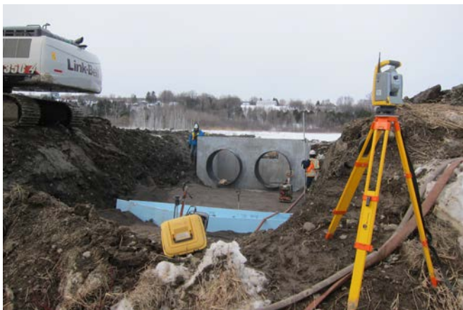
Installation de la nouvelle structure de contrôle de l'eau
