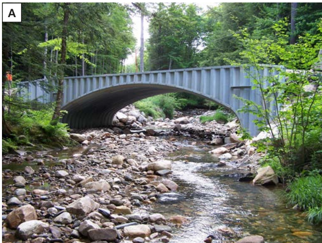
Figure 2. a) Un ponceau sur le ruisseau Bronson, au Massachusetts, qui n'a pas été conçu pour répondre aux normes optimales de franchissement des cours d'eau. Il représentait une barrière au passage des poissons et a cédé lors d'une forte pluie; b) La structure de remplacement a été conçue à l'aide de la méthode de simulation de cours d'eau: elle présente une grande ouverture par rapport à sa longueur, la largeur du passage est d'au moins 1,2 fois celle de la largeur au débit de plein bord, et le substrat correspond au lit naturel du cours d'eau. Cette structure a résisté aux inondations de la tempête tropicale Irène sans être endommagée.
