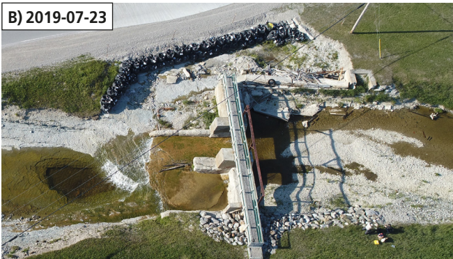
Figure 5. Dégradations du canal Saint-Georges : A) en berge concave au niveau du coude (350 m) en 2019; et dans la zone du barrage X2092719 démantelé (475 m) B) le 23 juillet 2019; C) le 27 août 2021.
