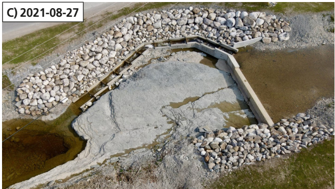
Figure 5. Dégradations du canal Saint-Georges : A) en berge concave au niveau du coude (350 m) en 2019; et dans la zone du barrage X2092719 démantelé (475 m) B) le 23 juillet 2019; C) le 27 août 2021.
