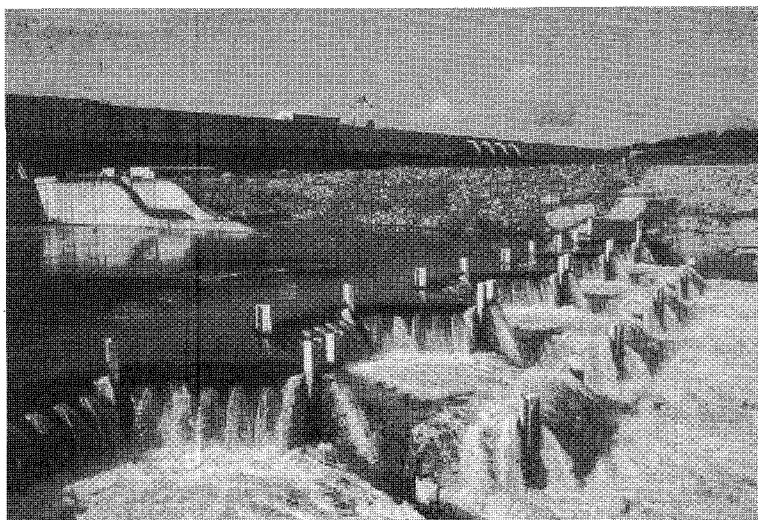
Figure 6 Seuil à lames déversantes dans sa configuration initiale. Aerating weir in the initial configuration.
