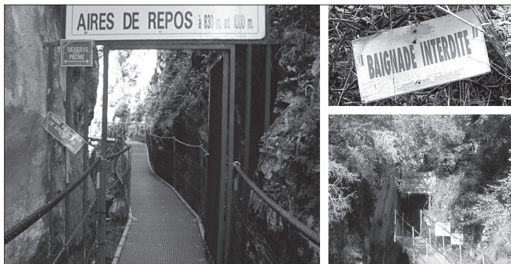
ILLUSTRATION 2 : Grille scellée dans la roche et panneaux d'entrée dans les Gorges de la Fou (photos : André Suchet).
