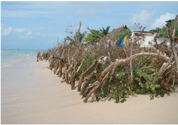
A. La protection de l'habitat contre les risques liés à la mer dans les quartiers pauvres de Betio, capitale de Tarawa Sud (Kiribati): branchages et déchets (cliché V. Duvat, 2010).
