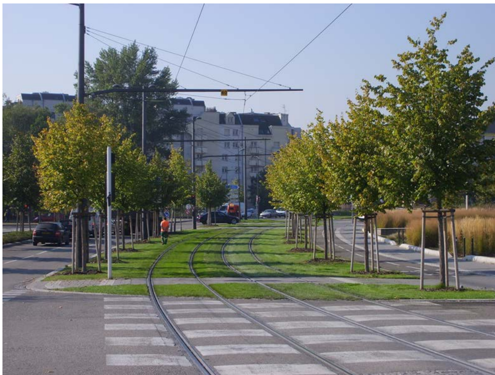
Figure 6. Verdissage des voies de tram à Strasbourg : engazonnement des emprises et plantations d'arbres, arrêt Pont Churchill
