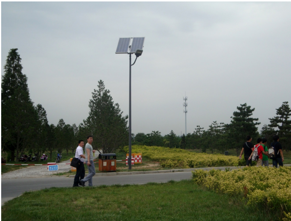
Figure 9. Éclairage urbain alimenté par panneau solaire, Xian, juin 2013.
