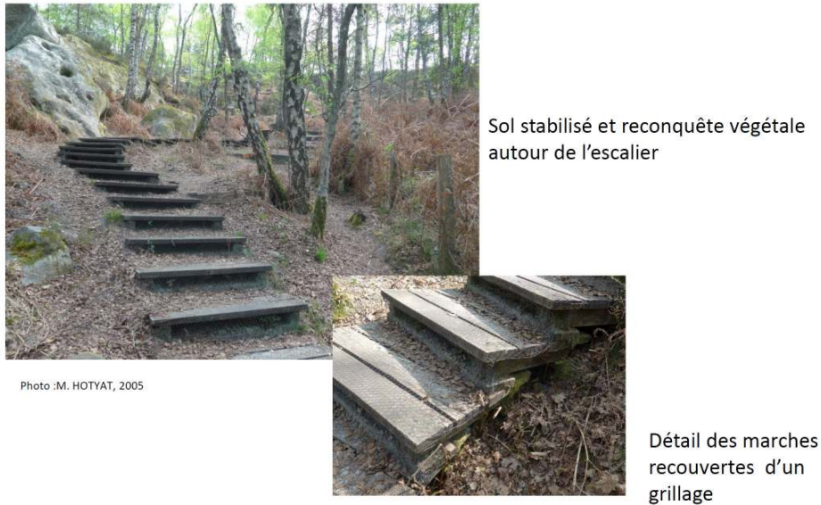
Figure 3. Restauration d'une ravine sur le versant de la platière d'Apremont avec la création d'un escalier hors sol.
