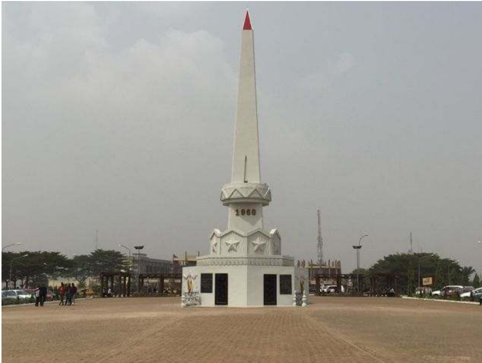
Figure 7. Une vue du monument de l'indépendance nouvellement construit au quartier Hippodrome.
