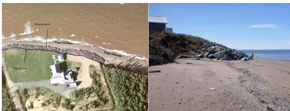
Figure 9. Perte de superficie de plage occasionnée par les enrochements dans le secteur de Salmon Beach ouest : noter la différence de largeur entre la plage naturelle et la plage enrochée.
