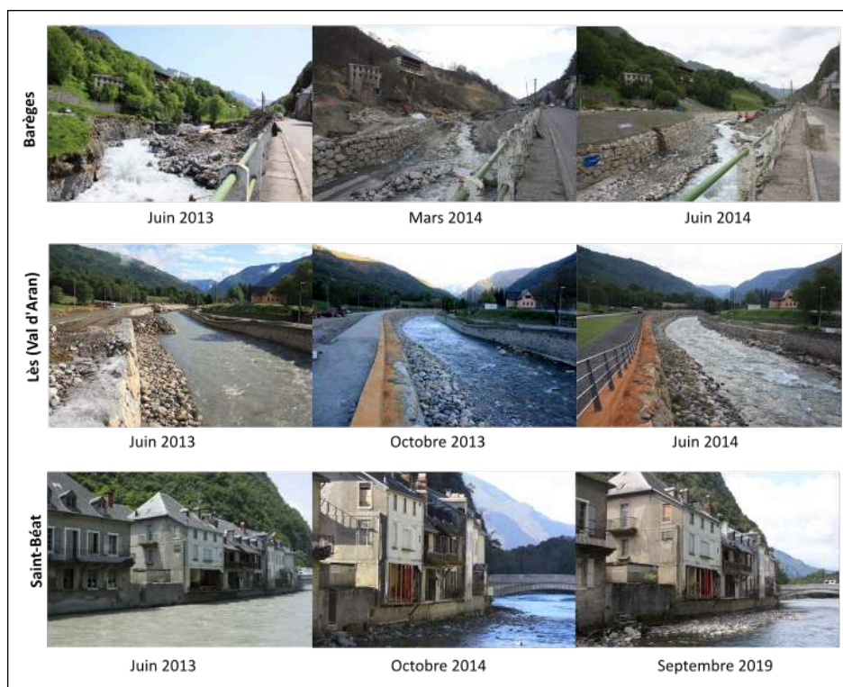
Figure 14. Photocomparaison du rythme de la reconstruction après la crue de juin 2013 dans les vallées de la Garonne espagnole, de la Garonne française et du Bastan (localisation figures 2 et 3) / Photocomparison of the rate of reconstruction after the June 2013 flood in the valleys of the Spanish Garonne, the French Garonne and the Bastan (location figures 2 et 3)
