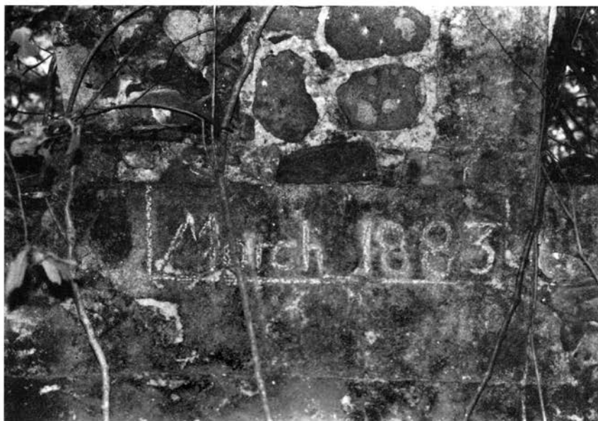
Fig. 4. – Date : mars 1883, gravée au-dessus des chaudières.
