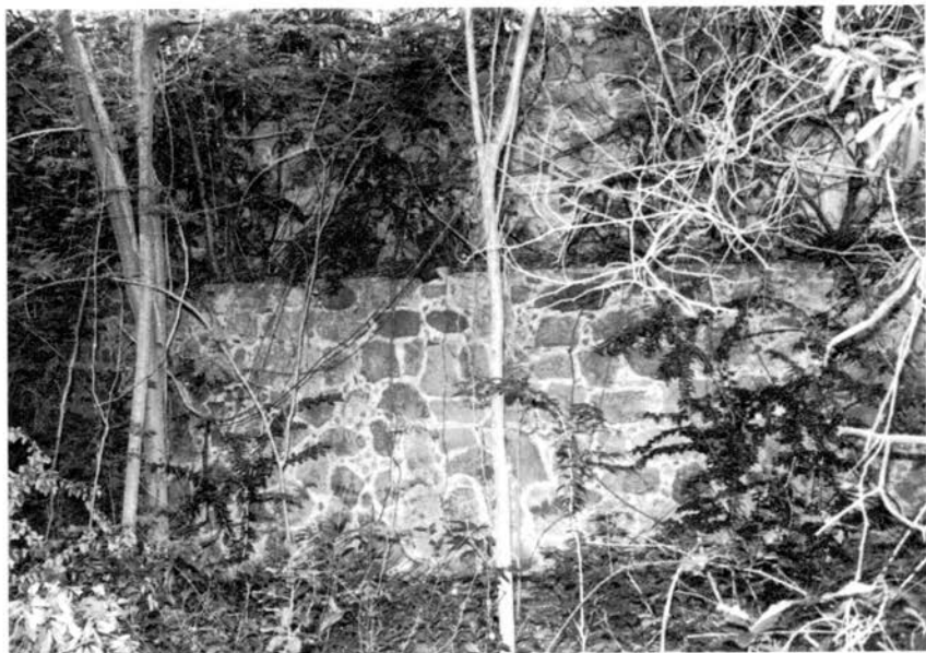
Fig. 2. – Moulin à bêtes vu de l'extérieur. En bas : le muret de soutènement de l'ancien moulin à un niveau. Au-dessus, ajouté postérieurement : le 2 e niveau excentré.
