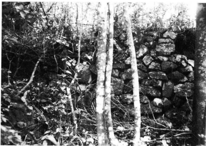
Fig. 17. – Muret de soutènement du moulin à bêtes à 1 niveau. Il s'agit d'un muret en gros blocs de pierres sèches.
