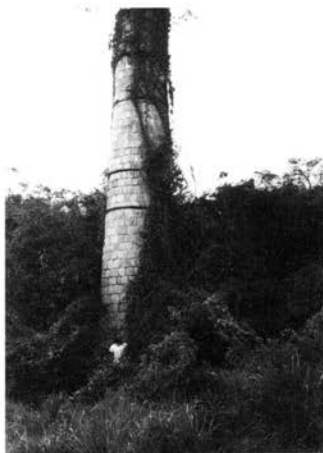
Fig. 6. – La cheminée en pierre de taille.
