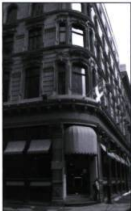
L'immeuble de la Régie du cinéma, rue Notre-Dame à Montréal
