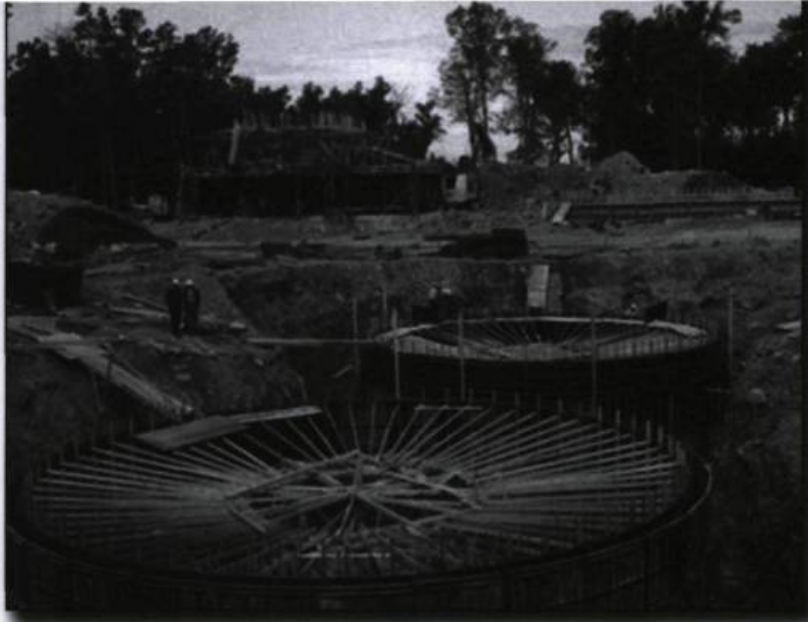
■ Chantier de construction de l'usine d'épuration des eaux de Sainte-Thérèse et de Saint-Eustache, bassin de sédimentation. Régie d'épuration des eaux. Photo Claude Gosselin, 1963. (Bibliothèque et Archives nationales du Québec, Fonds ministère de la Culture et des Communications, Cote : E6, S7, SS1, D 31469).
