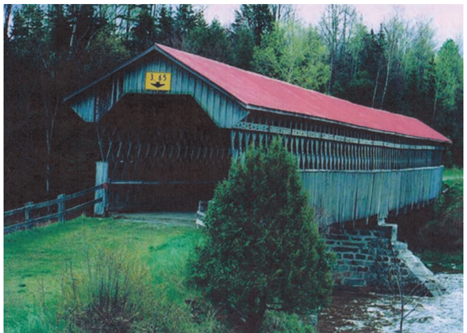
Les ponts couverts ont été la pierre angulaire de la colonisation de 1815 à 1955. Sur cette photographie, le pont McVetty-McKerry, à Lingwick, en Estrie, construit en 1893. (Ministère des transports du Québec).
