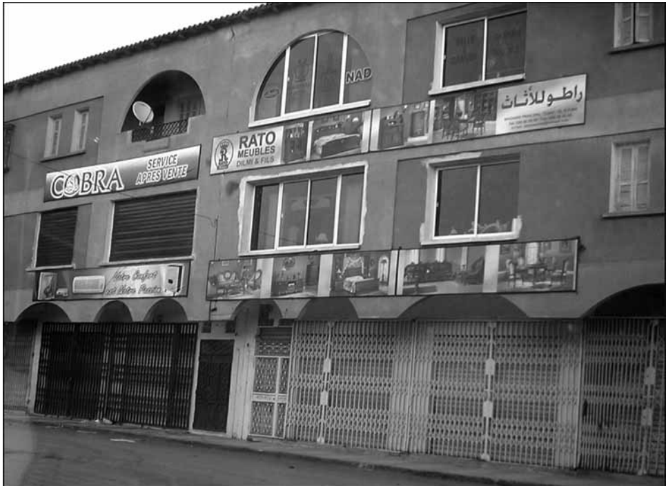
Figure 6 Immeuble d'habitations transformées en locaux commerciaux (El Eulma)
