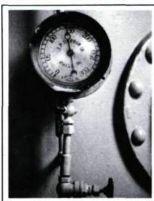
Cadran indicateur de pression à l'intérieur de la bache spirale d'une turbine installée en 1911 à la centrale Shawinigan-2. Cette turbine fonctionne toujours.
