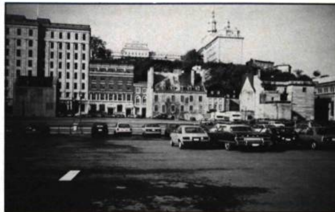
Le site du futur Musée de la civilisation, à l'îlot Fargues à Québec. Un projet passablement modifié grâce aux pressions des intervenants du milieu.
