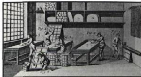
9. Gravure illustrant plusieurs des gestes anciens rattachés au vitrage des fenêtres. (photo tirée de: «Encyclopédie de Diderot et d'Alembert», XVIII e siècle)
