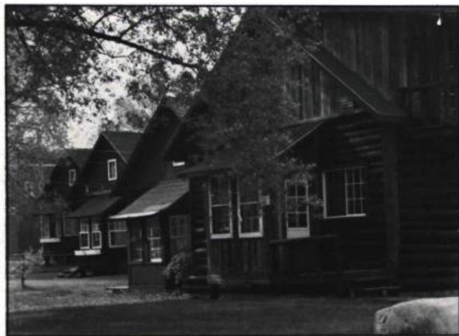
Quelques-unes des 69 maisons de bois rond du Village minier de Val d'Or. Peu après sa construction en 1935 et depuis qu'il est protégé par un règlement de zonage municipal (1980).
